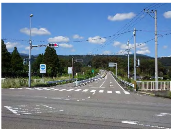
都農インターチェンジ入口
