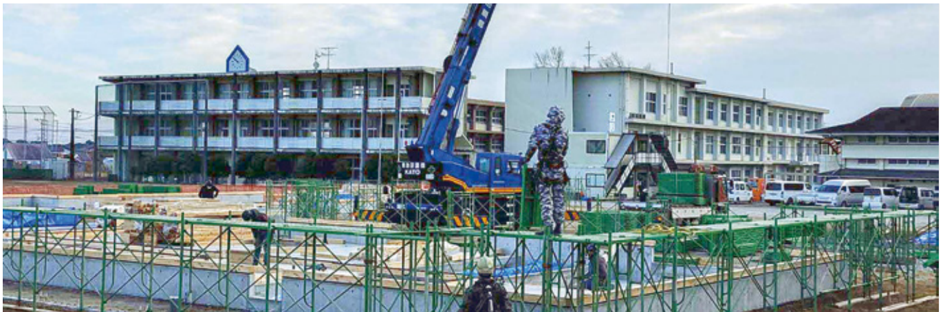
建設工事中の中央保育所園舎（令和8年1月7日撮影）
