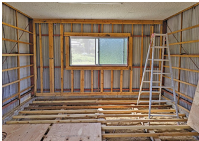
リフォーム事業の改修の様子
