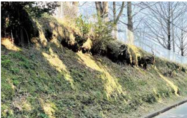
町道坂の上8号線のり面
